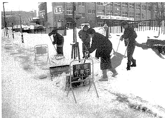
写真-1 歩道上の積雪を流雪溝へ投入する
