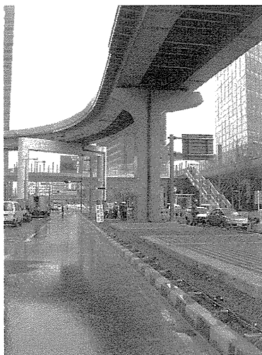
写真-2 汐留地区での道路散水状況
