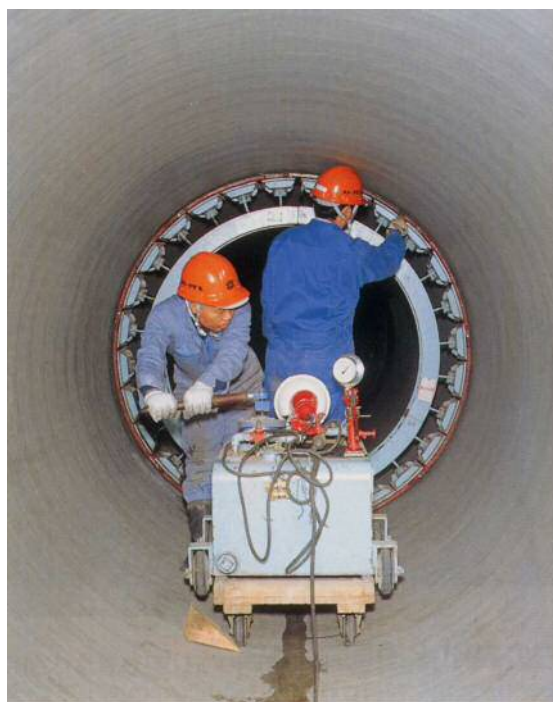
写真2 テストバンドによる継手部水密試験
