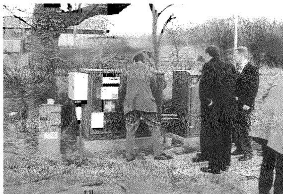
写真2-2 中継ポンプ場制御盤
