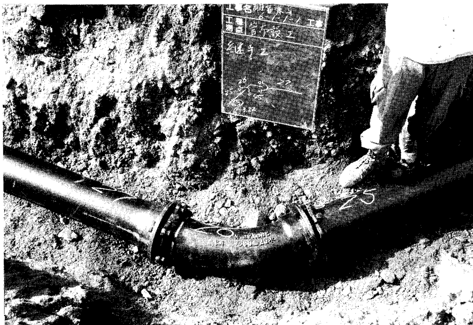
写真-6 締付トルクの確認
