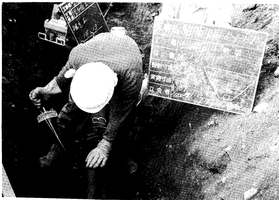
写真-6 締付トルクの確認
