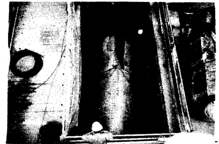
推進用マシンの初期掘進後、発達立坑内に管を降ろす。
