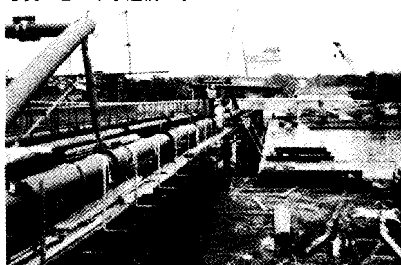
写真-2 下水道橋工事
