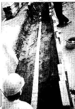
写真-5 埋設管明示シート敷設
