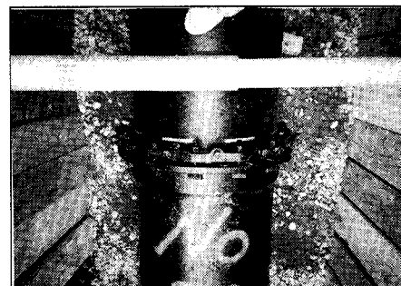
写真-2 特殊押輪の施工状況
